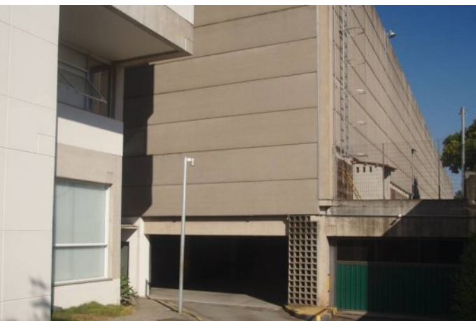
Entrada para a garagem no subsolo com 46 vagas.
