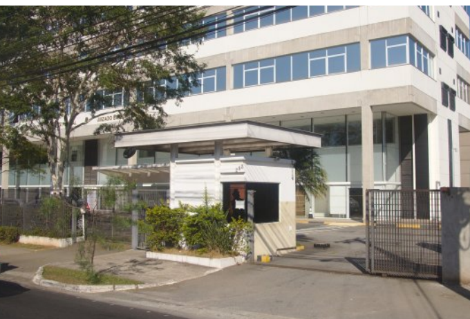
Portaria do edifício com controle de entradas e saídas.
