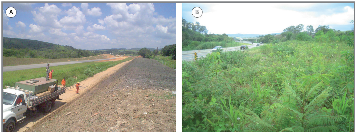
Detalhe do equipamento de hidrossemeadura durante aplicação (A) e área hidrossemeada em processo de recuperação em Sorocaba, na SP-270, sob concessão da CCR-ViaOeste (B)
