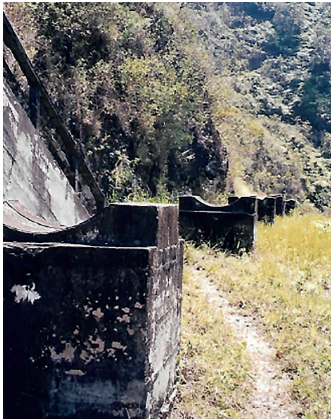
Fig. C5.8 Pilaretes de apoio ao by pass em alinhamento paralelo ao eixo do túnel (foto de 1999)
