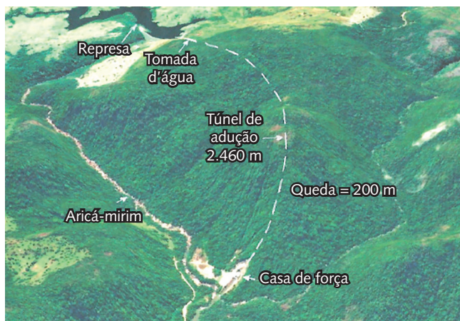
Fig. C8.1 Localização do empreendimento Fonte: Google Earth, imagem de 1º de abril de 2020.
