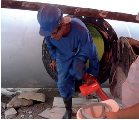
Fig. C8.6 Acesso ao interior do túnel de adução realizado, após o acidente, através da escotilha no conduto forçado externo Fonte: Kanji (2017).
