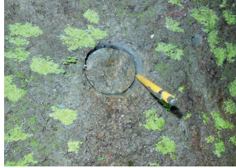
Fig. 2.9 Retirada de amostra de parede com sonda rotativa, para verificar a espessura do concreto projetado e realizar ensaios de laboratório
