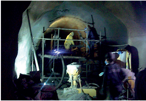
Fig. C9.5 Execução de concreto projetado em plena seção do túnel
