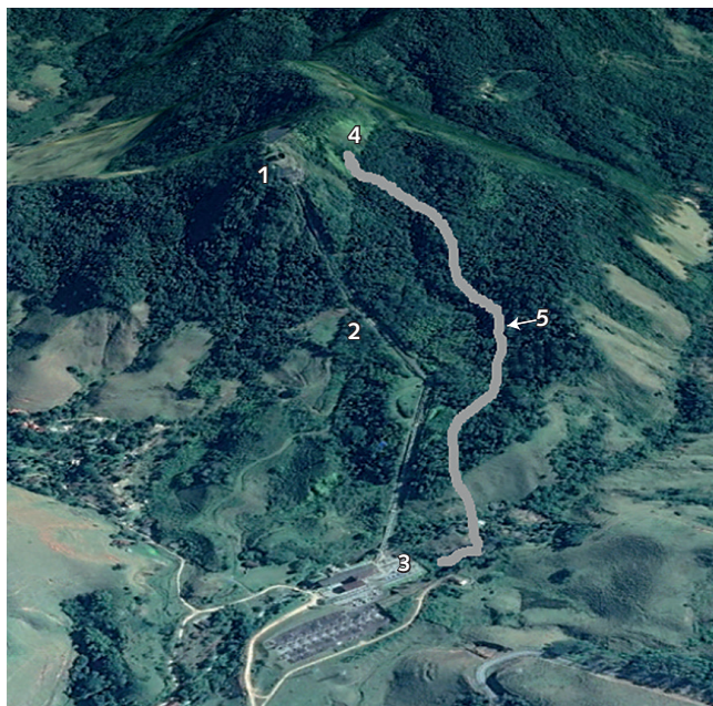
Fig. C5.10 Chaminé de equilíbrio (1), condutos forçados (2), casa de força (3), local da ruptura do túnel de adução (4) e provável trajetória da corrida de lama e detritos (5)
