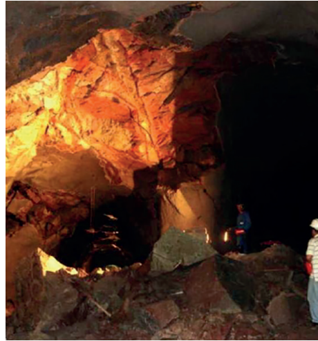
Fig. 2.13 Vista dos danos sofridos pelo túnel de adução da PCH São Tadeu I, no trecho revestido com concreto projetado, a montante do término da blindagem metálica e do trecho de transição em concreto armado
