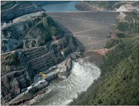
Fig. C1.4 Reservatório sendo esvaziado pelo túnel 2 Fonte: Xavier (2009b).
