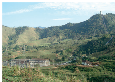
Fig. C5.3 Casa de força da PCH Macabu em primeiro plano e, no alto, a chaminé de equilíbrio. Os condutos metálicos cobrem uma queda de 330 m, aproximadamente Fonte: Freitas et al. (2014).
