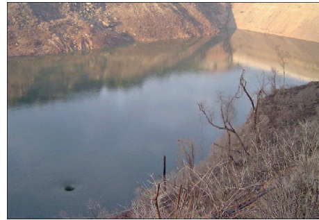
Fig. C1.5 Redemoinho na superfície da água sinalizando o avanço do processo de esvaziamento do reservatório Fonte: Xavier (2009b).
