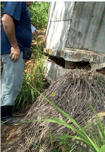
Fig. C10.3 Bloco de ancoragem deslocado, expondo as estacas raiz
