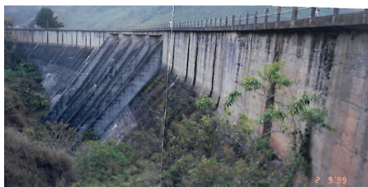
Fig. C5.2 Barragem em arco gravidade (foto de 1999)
