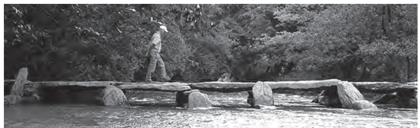
Fig. 1.10 Ponte pré-histórica Tarr Steps em placas de pedras biapoiadas Fonte: Stefan Kühn (CC BY-SA 3.0, https://w.wiki/Le2 ).
