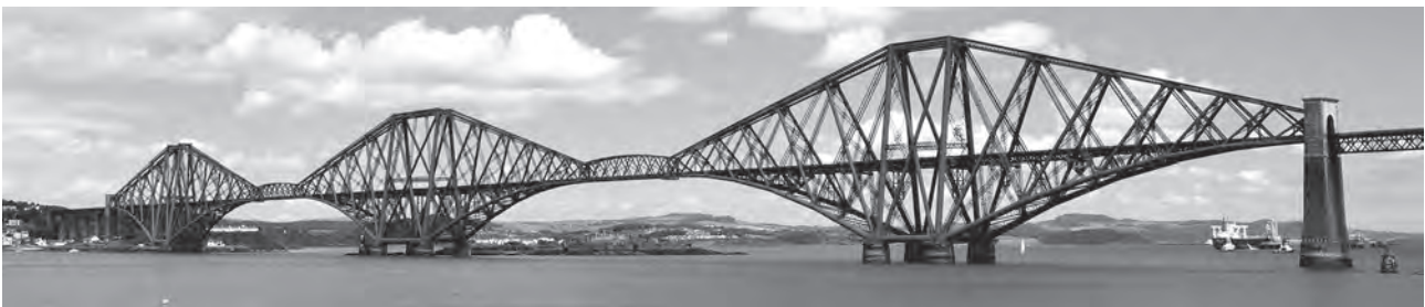
Fig. 3.29 Sistema estrutural em treliça metálica – ponte de Forth, na Escócia
