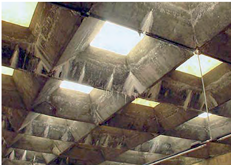
Fig. 2.12 Prédio FAU/ USP, com manifestações típicas de ataque por chuva ácida Fonte: Santos (2011).
