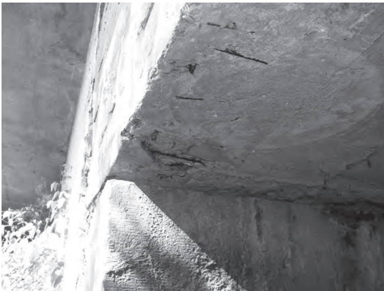
Fig. 2.77 Vista inferior da viga caixão de ponte de concreto armado
