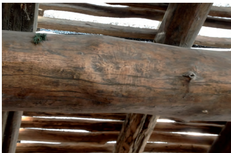
Fig. 4.19 Perfurações na superfície de madeira, típicas de um ataque por carunchos Fonte: Moreira (2009).
