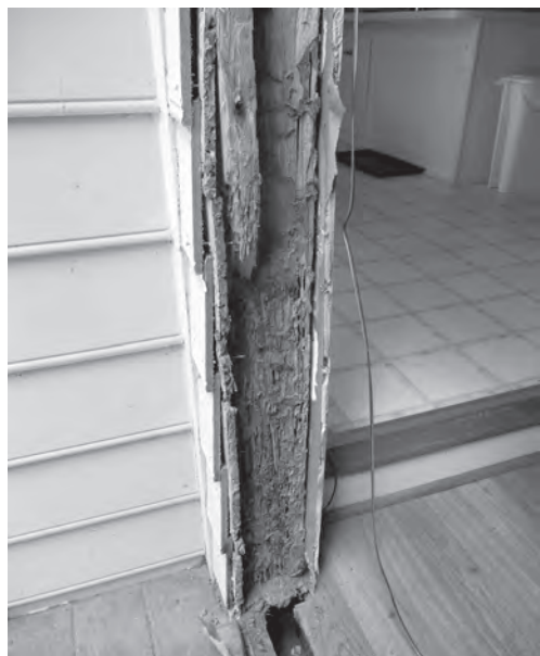
Fig. 4.14 Profundidade de ataque por térmita em uma madeira
