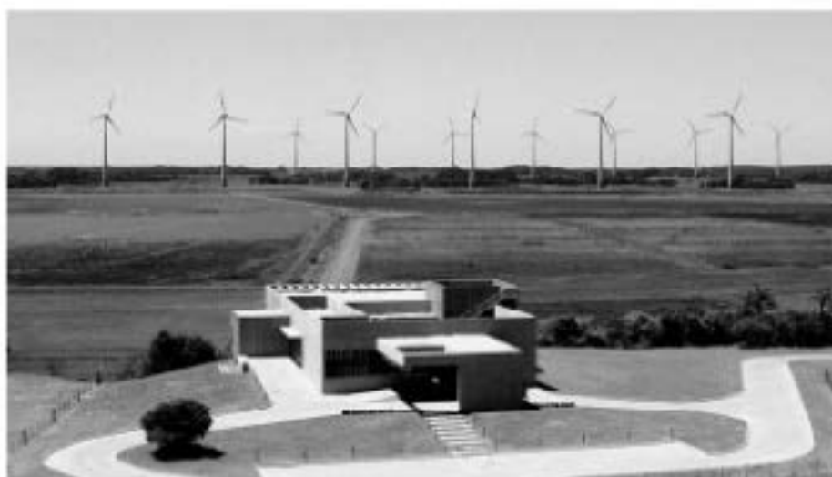
Figura 1.12 Parque eólico de Osório – RS. (Cortesia Enerfin, Espanha.)
