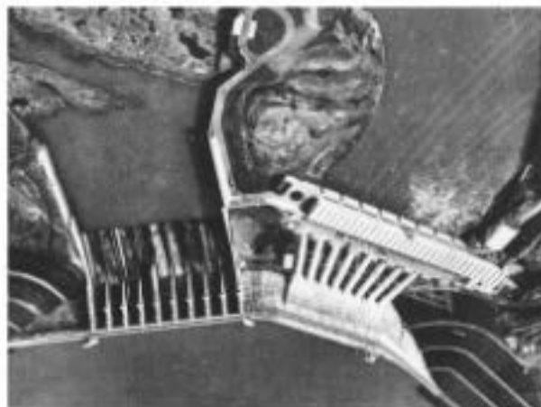
Figura 1.4 Usina hidrelétrica de Marimbondo – Furnas, com oito geradores de 180 MVA.
