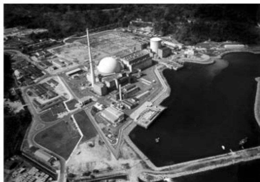
Figura 1.15 Usina nuclear de Angra 2. (Divulgação Eletronuclear.)
