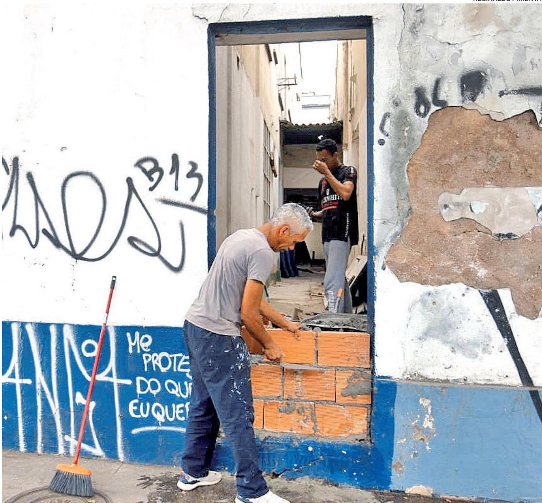
Acesso ao prédio na Avenida Venezuela, no Centro do Rio, é fechado após ação de desocupação
