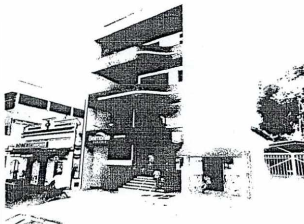
FOTO Nº 02/04 – Ilustra fachada do imóvel
