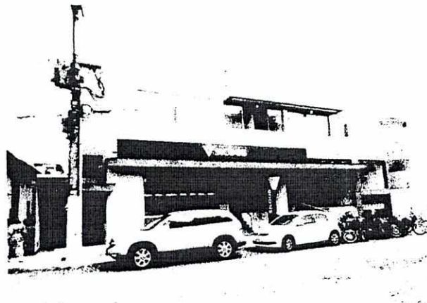
FOTO Nº 02/04 – Ilustra fachada do imóvel
