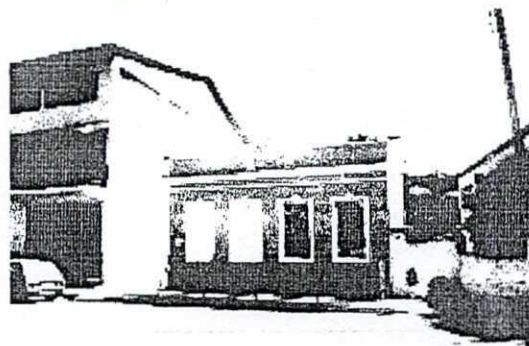
FOTO Nº 04/04 – Ilustra fachada do imóvel
