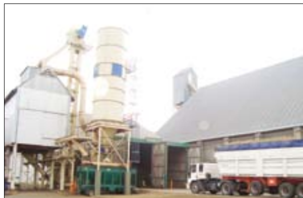
Área de descarga.
