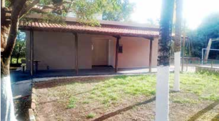
A Central de Penas e Medidas Alternativas (CPMA) de Jales contribuiu para a reforma e pintura do vestiário da Associação dos Funcionários Públicos do Município
