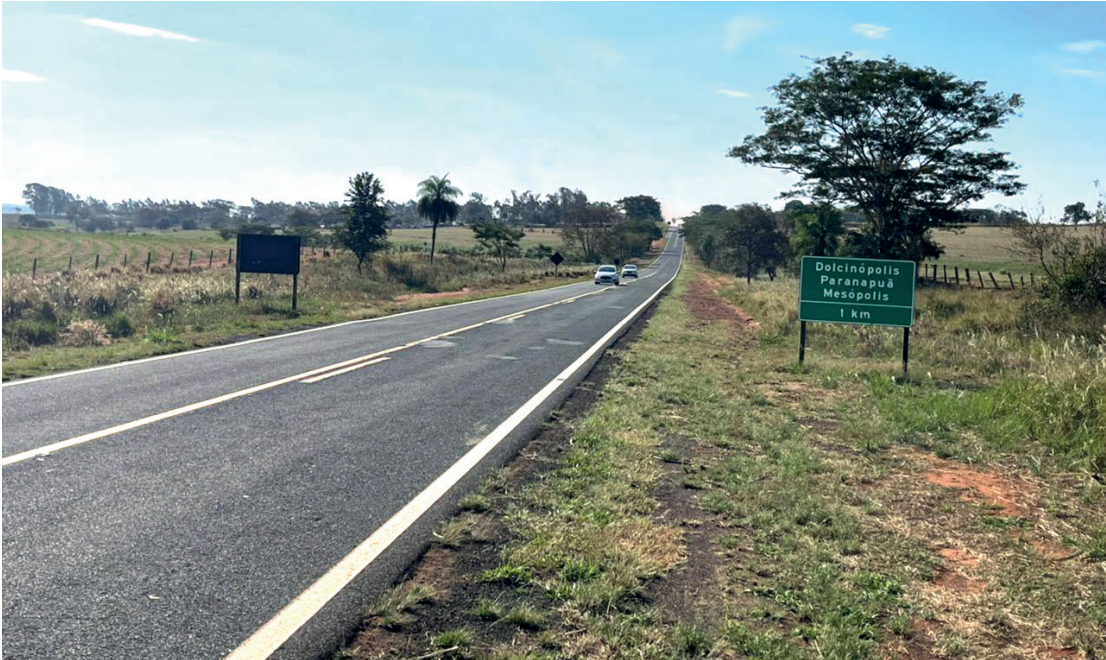
Serão investidos aproximadamente R$ 36 milhões nas obras de recapeamento asfáltico dos 43 quilômetros na estrada que liga Jales a Ouroeste, a SP 463 (Rodovia Dr. Elyeser Montenegro Magalhães)
