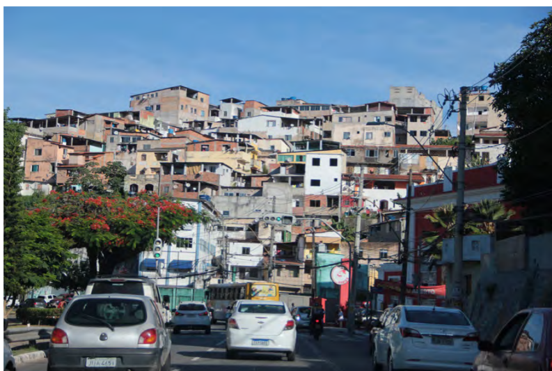
Figura 17 - Carência de água tratada e da correta disposição dos resíduos, exclusão social, ocupação de áreas irregulares, Salvador - BA
