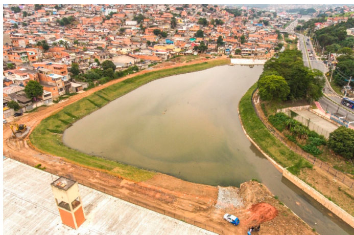
Figura 14 – Canalização e Piscinão em São Paulo
