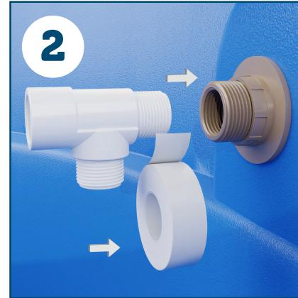
**Aplique fita veda rosca na extremidade macho do Tee, em seguida rosqueie no adaptador para caixa d'água. (Use níquel de 1/2 com fita veda rosca para adaptador caixa d'água 20x1/2).**
